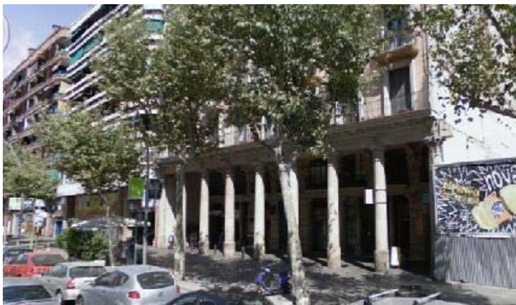
Casa Porticada. Avinguda del Paral·lel 102
